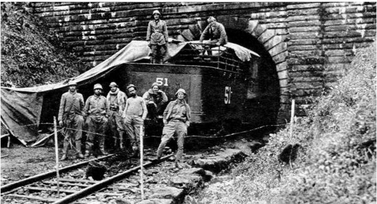
Defesa do túnel de Cruzeiro, na Serra da Mantiqueira, em São Paulo
